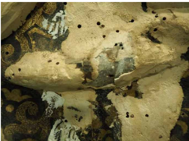
Estuco de tono amarillento y aspecto pulverulento de una intervención anterior.
